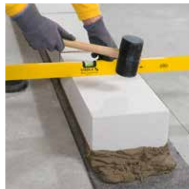
Poklepem gumovou paličkou se tvárnice srovná výškově i směrově.
