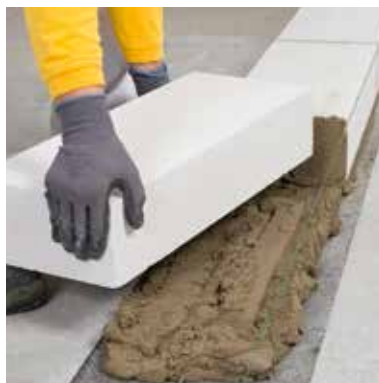
Zakládací tvárnice se pokládá do čerstvě nanesené zakládací malty.
