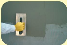
Pokud se vytváří základní vrstva, vkládá se skleněná síťovina do předem nanášené vrstvy stěrkové hmoty a vtlačí se dovnitř zahřazením nerezovým hladítkem směrem od středu ke krajům. Skleněná síťovina je v 1/3 tloušťky základní vrstvy od vrchu.
