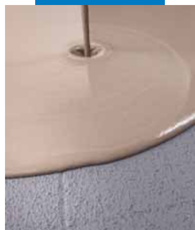
Nanášení samonivelační stěrky Ultraplán na suchý Eco Prim Grip aplikovaný na staré podlaze
